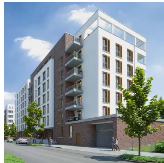
Preisgedämpfter Mietwohnungsbau im Neubauprojekt Bright Side, im Frankfurter Gallus-Viertel.
